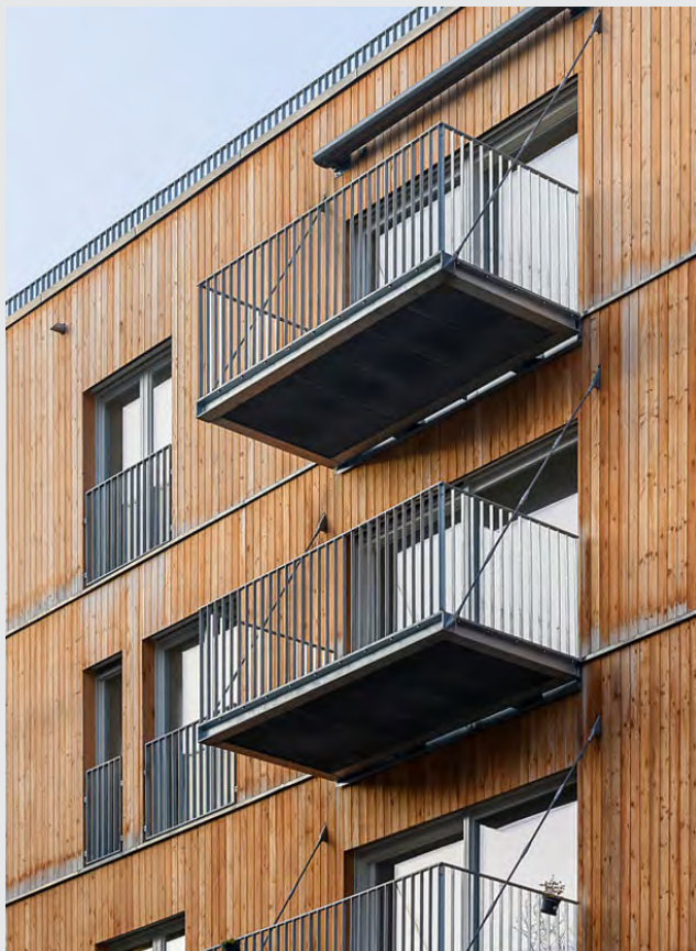
Balcons en porte-à-faux raccordés aux planchers bois grâce à Isokorb® T S.
