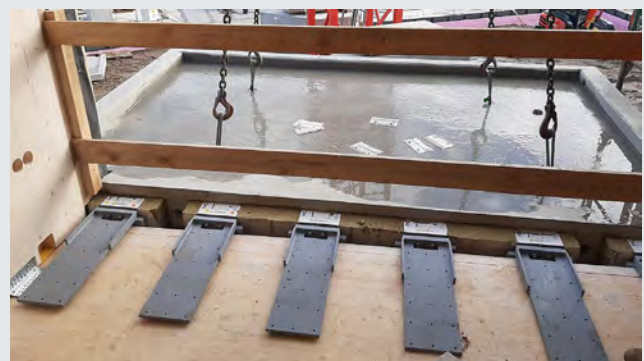
Dalle de balcon béton, préassemblée de rupteurs Isokorb® XT SK et de consoles d'acier fixée sur plancher bois.
